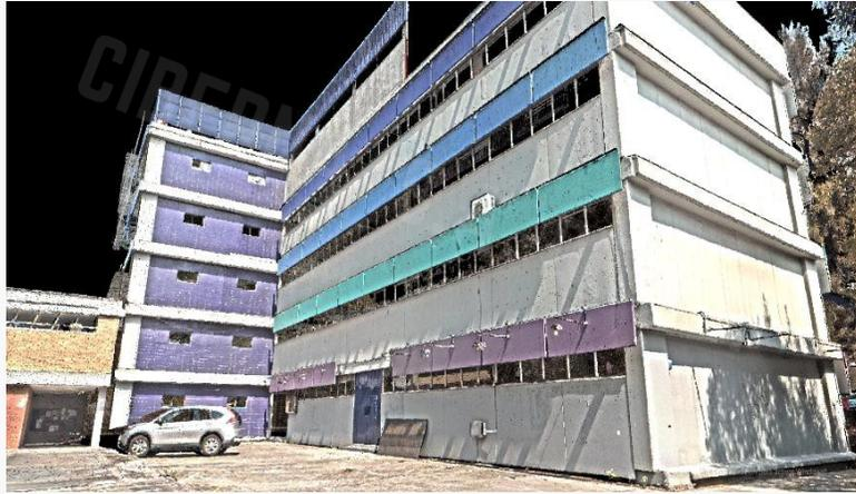
Para que generemos un modelo es necesario llevar a cabo un procesamiento y registro de información obtenida en campo. Como resultado se obtiene un modelo llamado nube de puntos 3D el cual consiste en una representación as-built del inmueble a color y con alto nivel de detalle.
