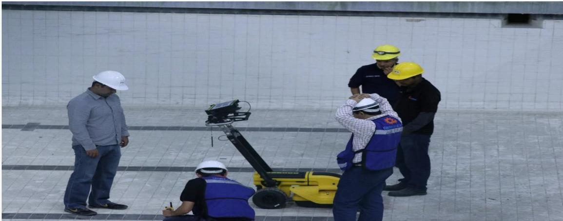
Como complemento utilizamos un localizador de cables que permite rastrear varias frecuencias, entre ellas las emitidas por nuestro transmisor de señales; y así poder ubicar las instalaciones subterráneas con mayor facilidad y precisión.
